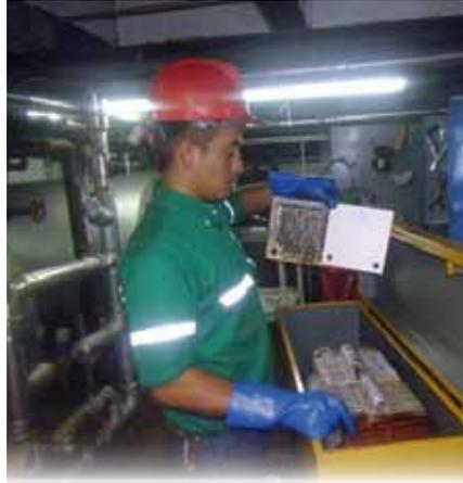
Limpieza técnica por filtro prensado en tanques de combustible en plantas eléctricas.
