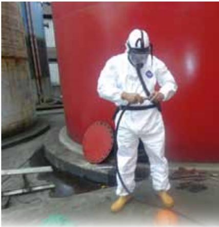
Mantenimiento y limpieza técnica de grandes tanques mediante sistema de incursión al espacio confinado.
